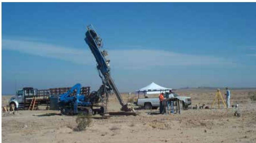
Рис. 10.8. Развертывание длиннобазового лазерного деформографа. Бурение наклонных скважин под оптические анкеры
